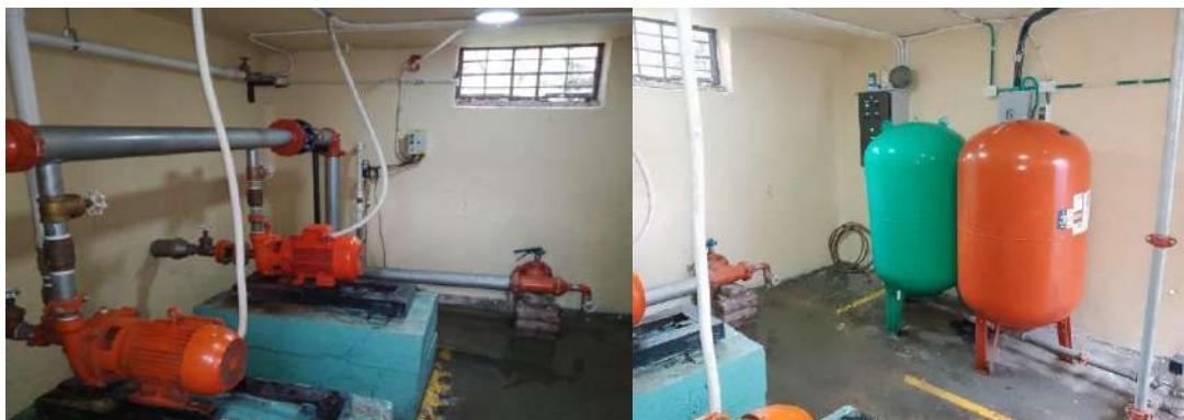
Se continuó con el mantenimiento intensivo tanto de las motobombas como de los hidroacumuladores de cada uno de los tanques de depósito de agua, igualmente se realizó como todos los años el lavado y desinfección semestral de los tanques de suministro de agua potable, labor que fue debidamente certificada por empresa autorizada e inscrita ante la Secretaría de Salud de Bogotá
